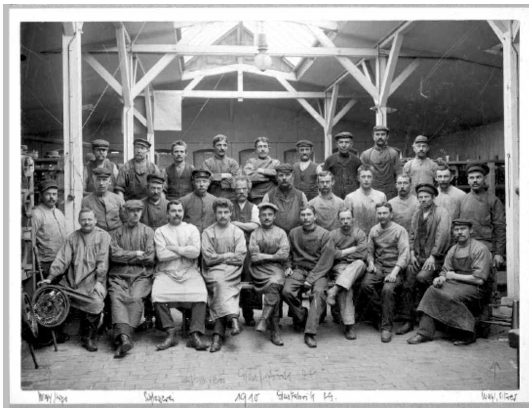
Abb. 2002-5-2/016 Glasfabrik AG Brockwitz, Arbeiter der Schlosserei 1910, links und rechts außen die Vorfahren von Herrn W., Sammlung Neumann
