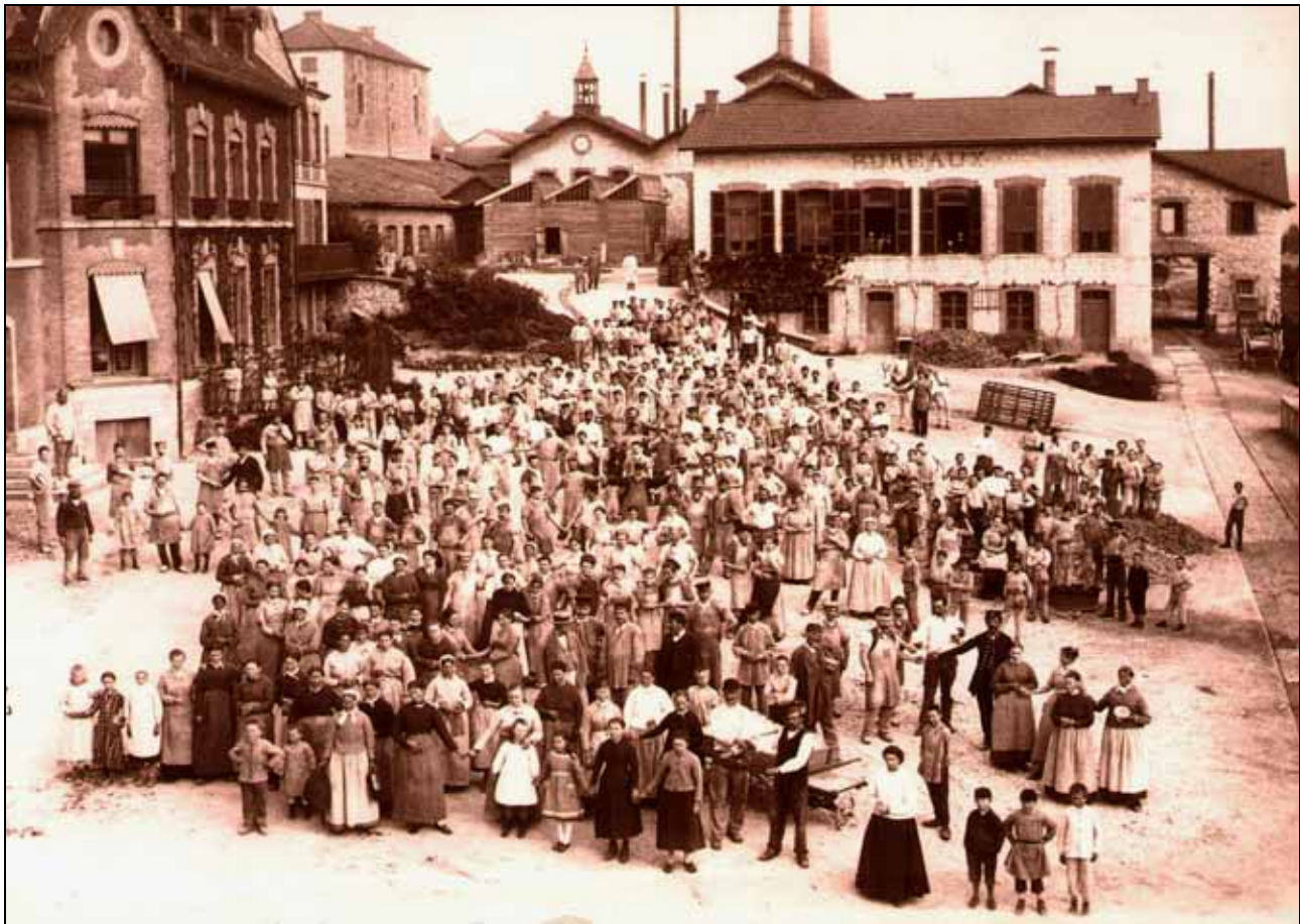
Abb. 2006-2/044 Verrerie de Bayel, Glasarbeiter auf einem Innenhof des Glaswerks an der rue Basse, im Hintergrund links das Herrenhaus «maison patronale», Gustave Marquot mit Melonenhut auf der Freitreppe [perron], rechts vor dem «Bureaux», eine «harasse d'expédition», rechts der Gleisanschluss des Glaswerks, Datum unbekannt, aus Humbert, Bayel 2003
