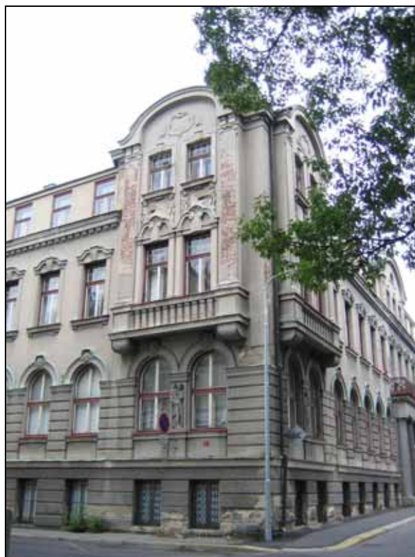
Abb. 2007-3/515 PK-Treffen Juni 2007 Rundgang in Jablonec nad Nisou ehemals Haus Heinrich Hoffmann, Fenster im Treppenhaus
