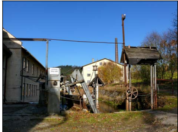
Schleif-Wohnhaus ohne den Kanal des Elektrizitätswerks 2016 Sowohl die Gerätschaften, als auch der E-Werkskanal sind bei dem Schleiferei-Gebäude verschwunden
